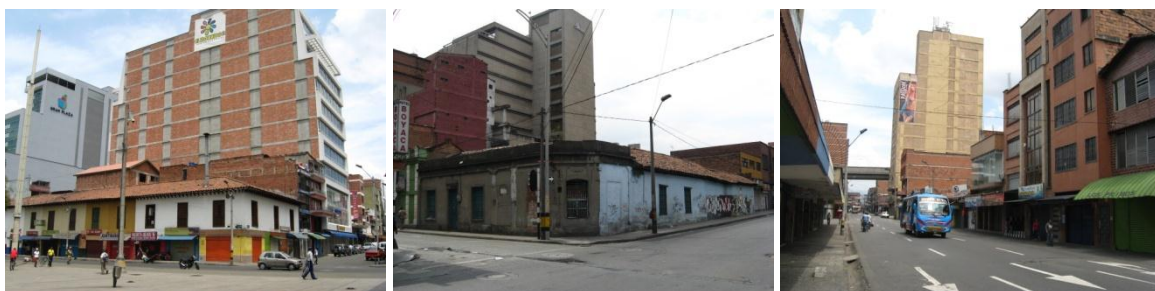
Foto 5. Fachadas cerradas o culatas de edificios entre medianeros que afectan el paisaje urbano del centro.
