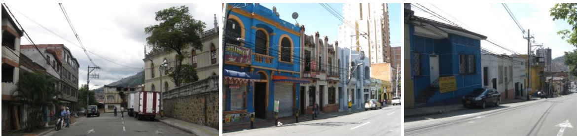
Foto 7. Redes aéreas, parqueo e invasión del espacio público en sectores de valor cultural.
