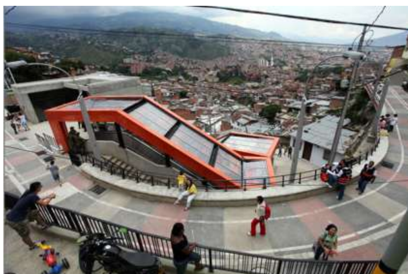
Figura 95. Vía Peatonal y Escaleras Mecánicas, Comuna 13 Medellín.
