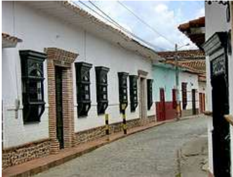
Figura 133. Adecuaciones en la superficie de rodadura como Elemento de adecuación de la sección vial para convertirla en una vía de tráfico calmado
