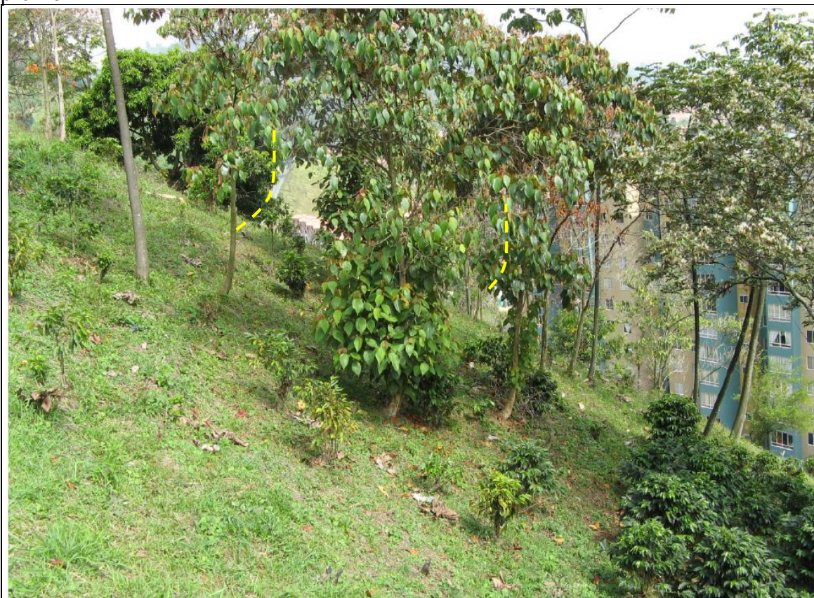
Foto 1 - Fenómenos de reptación superficial evidenciado en el crecimiento de los árboles
