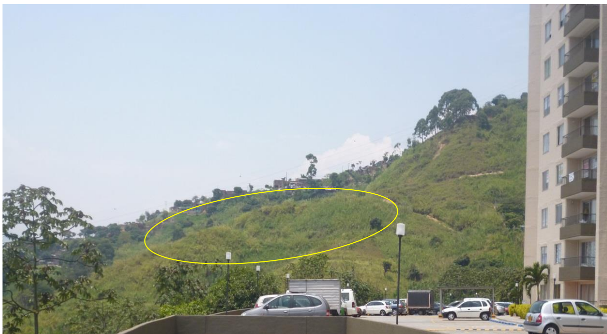
FIGURA 32. Vista panorámica del depósito de flujo de escombros, (depósito en amarillo) desde el parqueadero de la unidad residencial Rodeo Campestre
