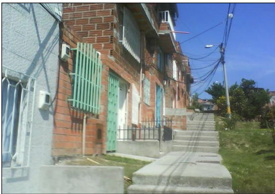
Calle peatonal residencial La Colinita
