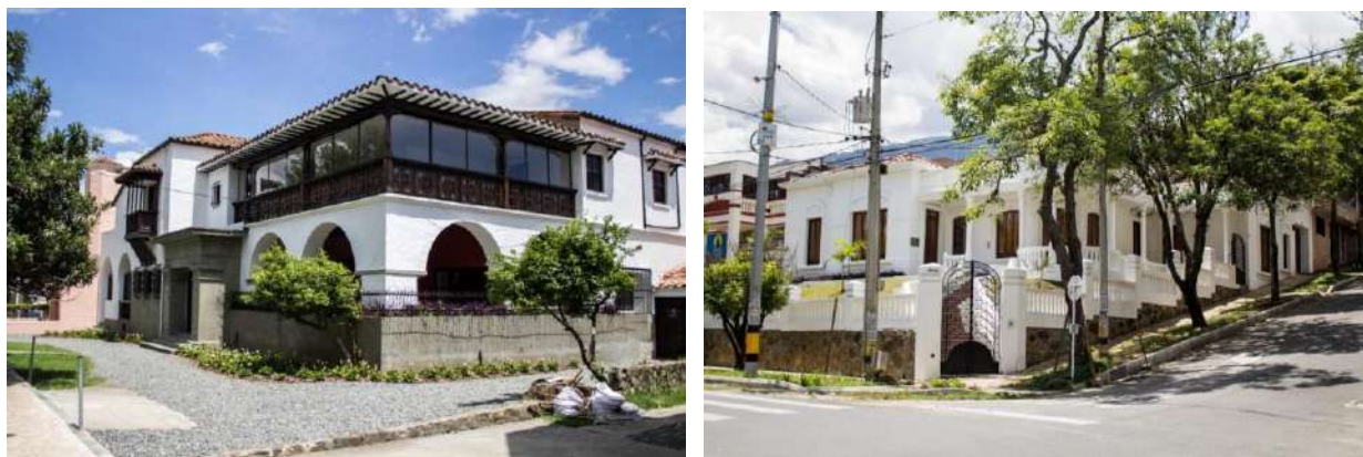
Foto 1. Fachadas intervenidas en el corredor Palacé barrio Prado.
