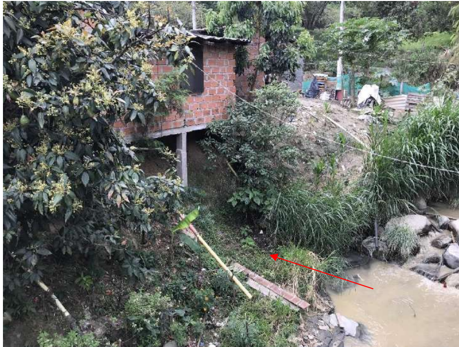
Figura 56. Socavación de llenos, barrió Betania, a la altura de la cantera La Esmeralda
