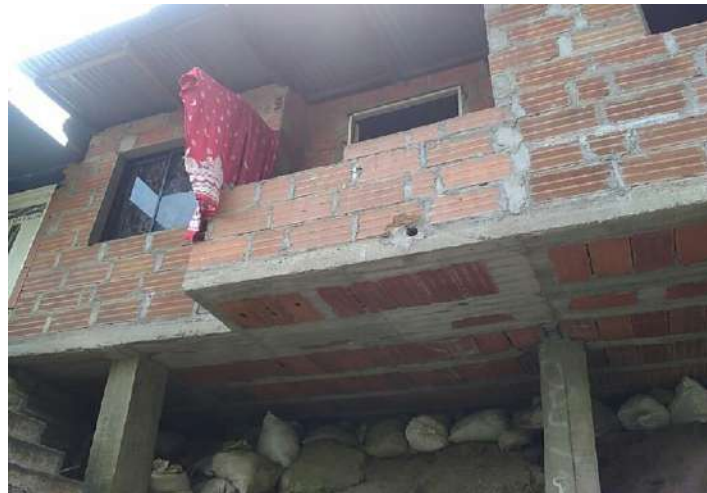
Figura 99. Tipología estructuras con confinamiento deficiente e híbridas (D). Estructura ubicada en el polígono Las Independencias.
