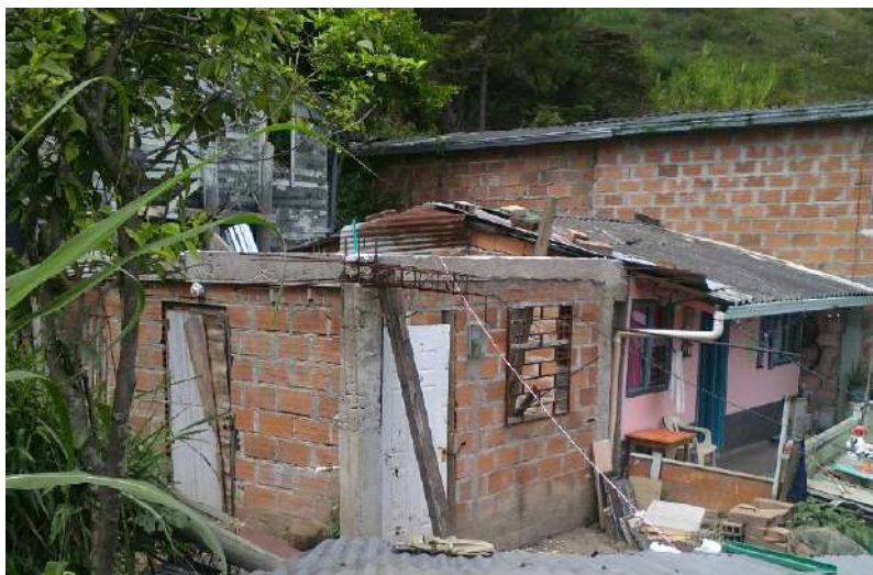
Figura 99. Tipología estructuras con confinamiento deficiente e híbridas (D). Estructura ubicada en el polígono El Salado.
