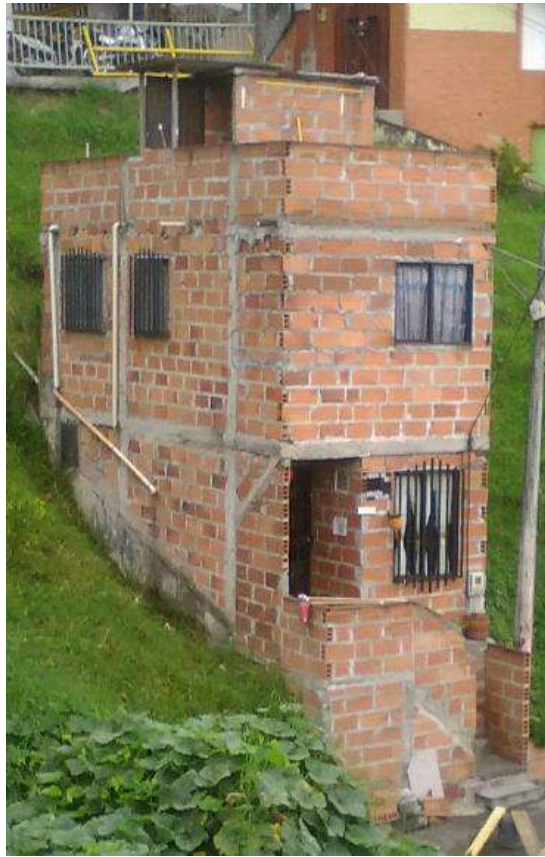
Figura 59. Tipología estructuras con confinamiento deficiente e híbridas (D). Estructura ubicada en el polígono Betania.
