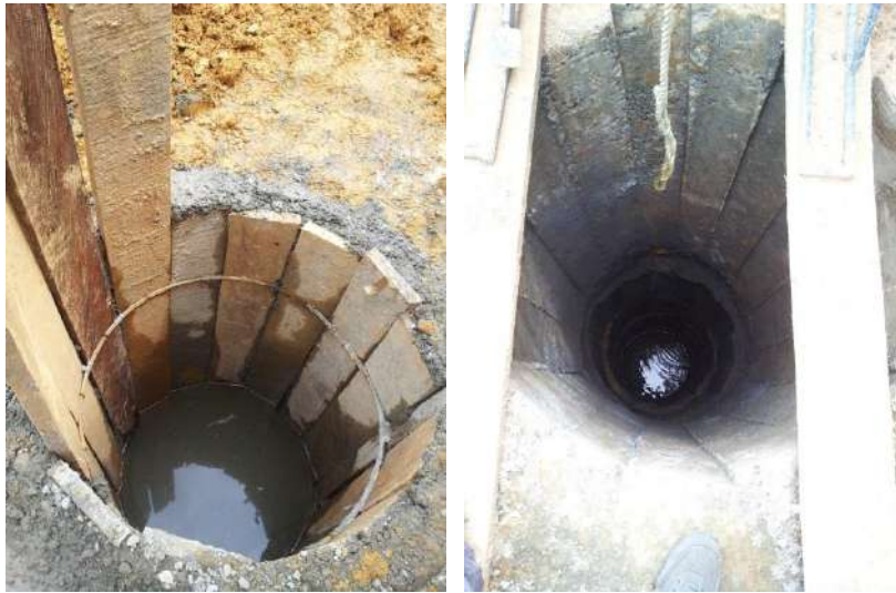
Figura 153. Construcción de una pila in-situ.
