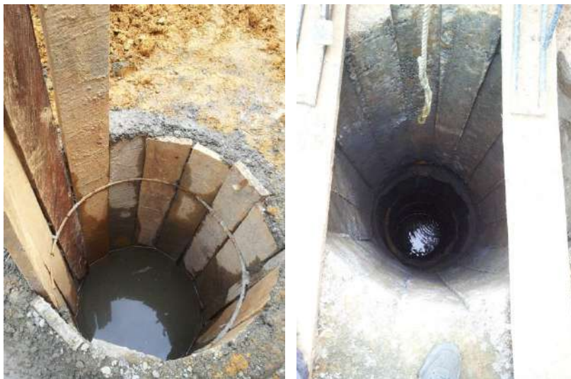
Figura 92. Construcción de una pila in-situ.
