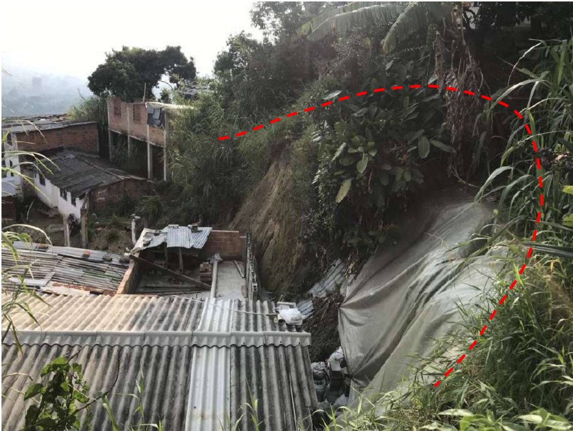
Figura 50. Zona de procesos activos, relacionados a los taludes que fallan a causa de inadecuado manejo de aguas de escorrentía.
