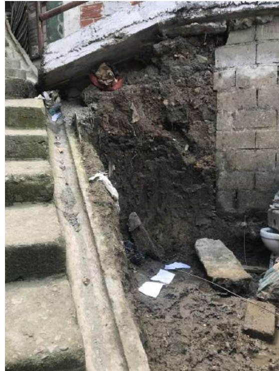
Figura 18. Características de los materiales que conforman el lleno antrópico, a la altura de la calle 34CC con carrera 111C.
