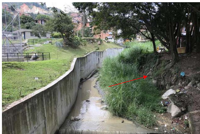
Figura 58. Socavación en el sector de Cr 93B con calle 34AA.
