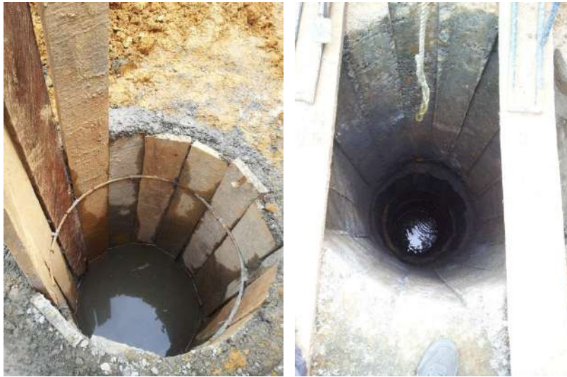
Figura 138. Construcción de una pila in-situ.
