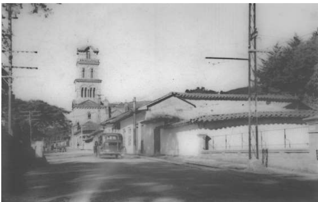
Imagen 23. Construcción de la actual Avenida El Poblado. Departamento Administrativo de Planeación. 2019
