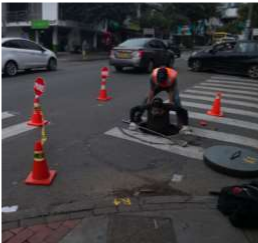
Imagen 27. Investigación de redes, accesos y diámetros de cajas de inspección. Soluciones Hidráulicas D-C SAS. 2019.
