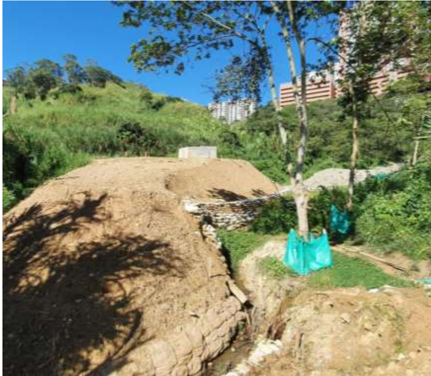
Ilustración 3. Trabajos en quebrada El Bolo por parte de EPM.
