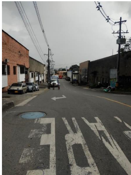
Ilustración 52. Fotografía Torre de energía calle 79b
