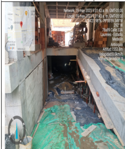
Imagen 3. Sótano del proyecto
