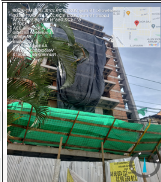
Imagen 5. Protección en lamina de zinc en frente y costado
