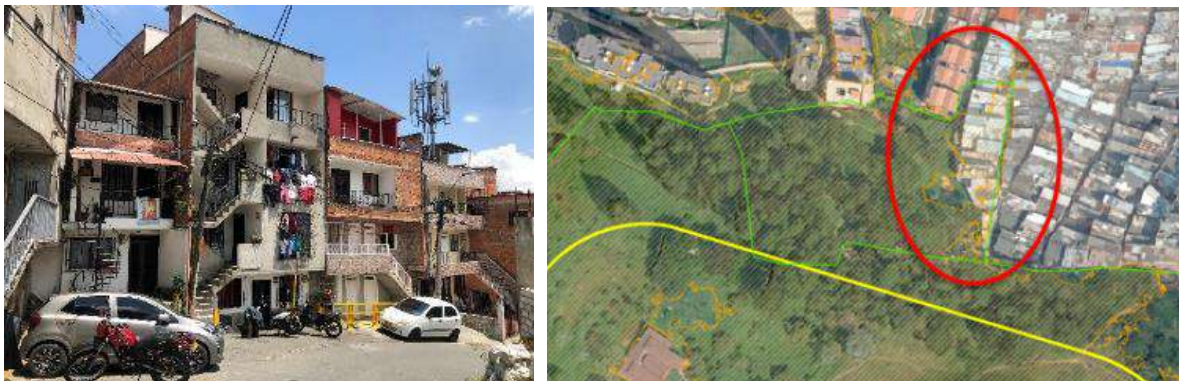
Figura 156. Estado de la consolidación de las edificaciones (izquierda), nueva ocupación informal (derecha)
