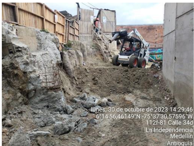
Figure 8 Demoliciones de estructuras en concreto reforzado... Ref. Tramo viaducto entre pilas 26 y 25
