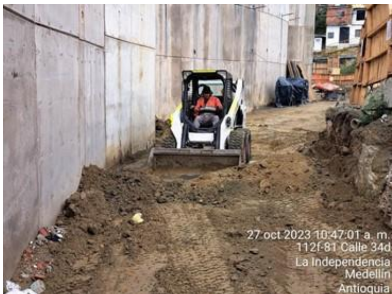
Figure 7 Movimientos de tierra viaducto
