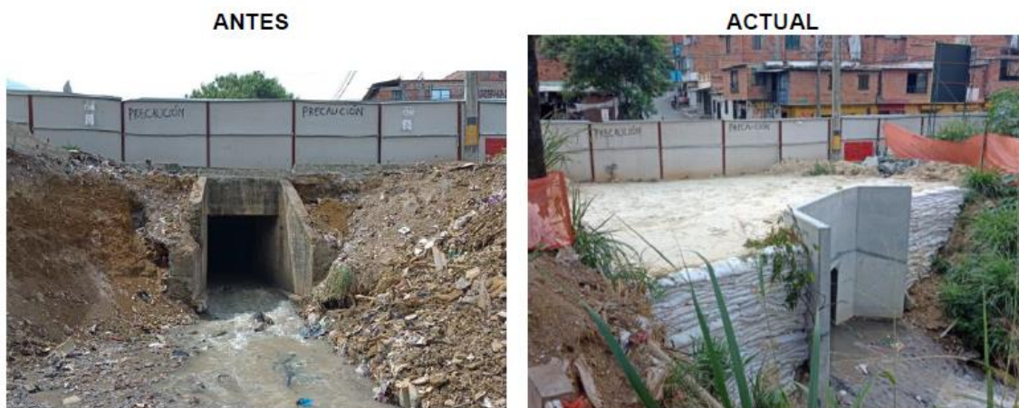
Figura 5 Fotografía antes y después ejecución de obras quebrada villa del socorro
