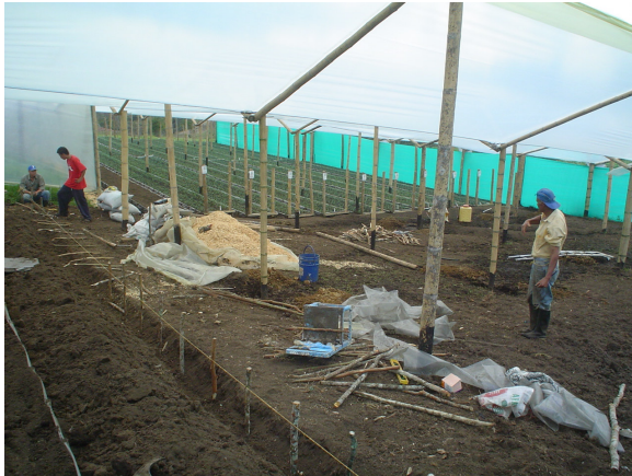
Imagen 4 Materiales y adecuación del terreno para construcción de camas.
