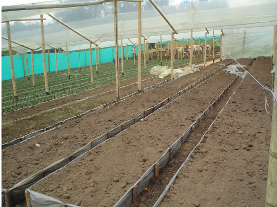
Imagen 1 Camas en proceso de construcción
