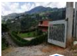
Portada en construcción en predio priorizado
