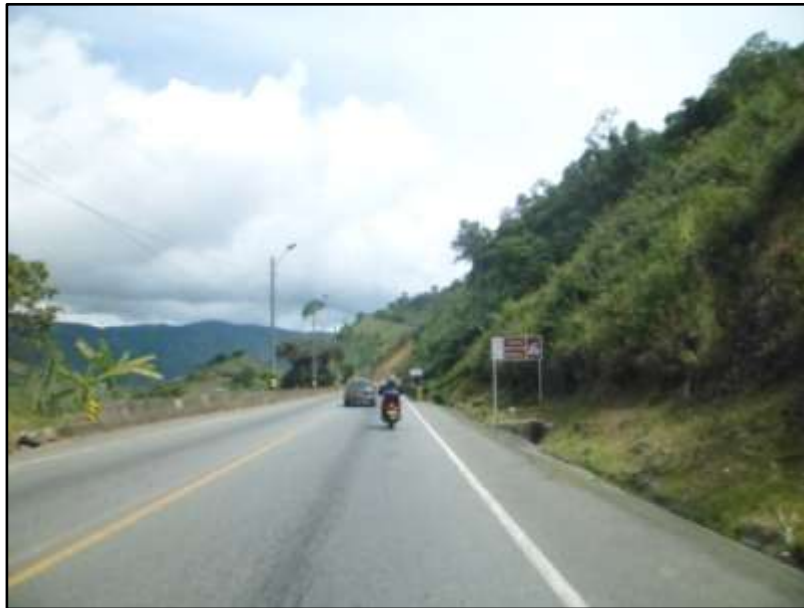
Foto 5 Conexión Vial Aburrá – Cauca y Señalización del Teleférico
