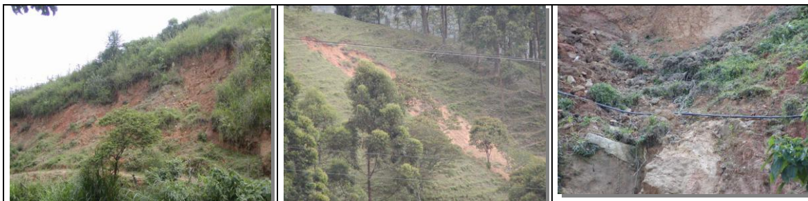
Sector Patio Bonito. Cárcavas y ensanchamiento por socavación y desplome.
