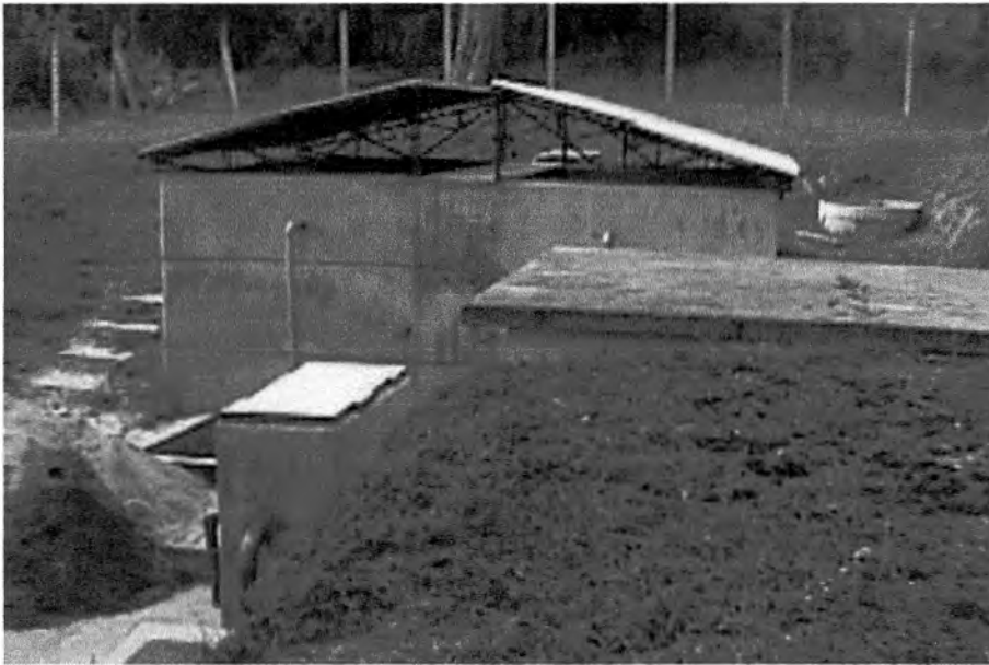
Planta de tratamiento del acueducto de Mazo
