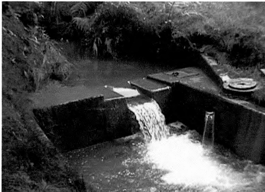
Bocatoma del acueducto Multiveredal Plan-Llano
