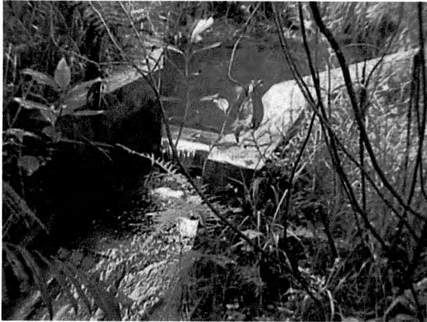
Bocatoma en el afluente derecho del acueducto de Mazo
