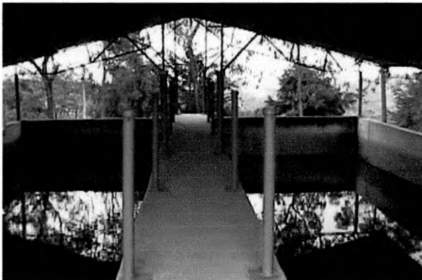
Planta de tratamiento del acueducto Multiveredal Plan-Llano
