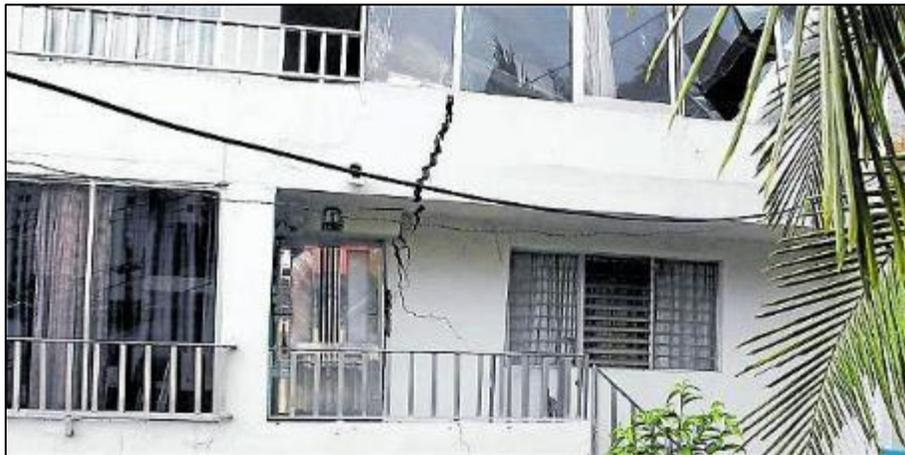
**Fotografía 4. Afectaciones estructurales producidas por la construcción del tranvía de Ayacucho**
