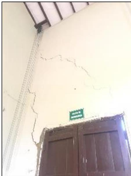
**Fotografía 18. Fisura en el muro occidental (zona sur)**
