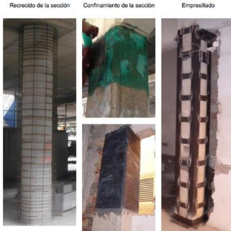
**Fotografía 49. Técnicas para reforzamiento estructural en concreto**
